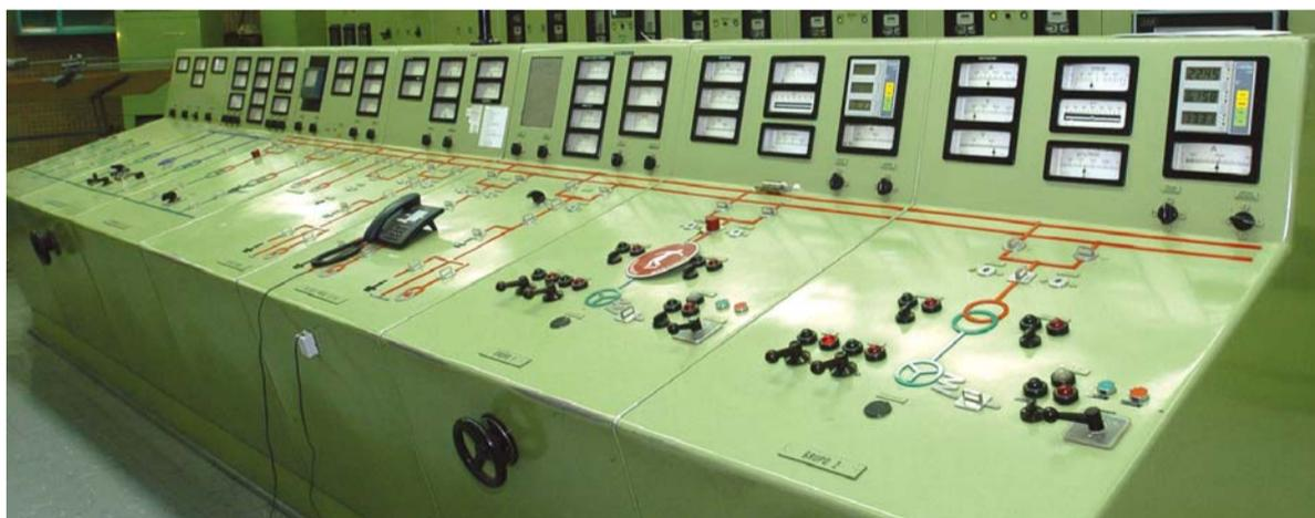
TABLERO. PARTE DEL INSTRUMENTAL QUE SE UTILIZA PARA EL MANEJO Y CONTROL DEL DIQUE FLORENTINO AMEGHINO Y SU CENTRAL HIDROELÉCTRICA
