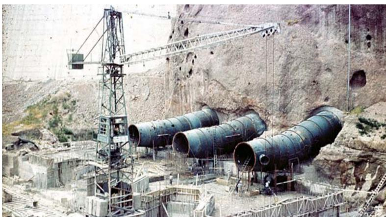
TUBERÍAS. EN UN PRINCIPIO SE PENSABAN COLOCAR TRES TURBINAS. ESTAS TUBERÍAS CONDUCE EL AGUA DENTRO DE LA CENTRAL PARA GENERAR ENERGÍA ELÉCTRICA.
